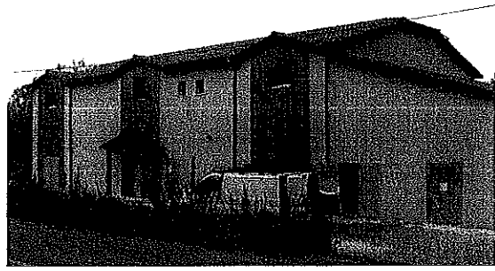
Station de traitement et de pompage
